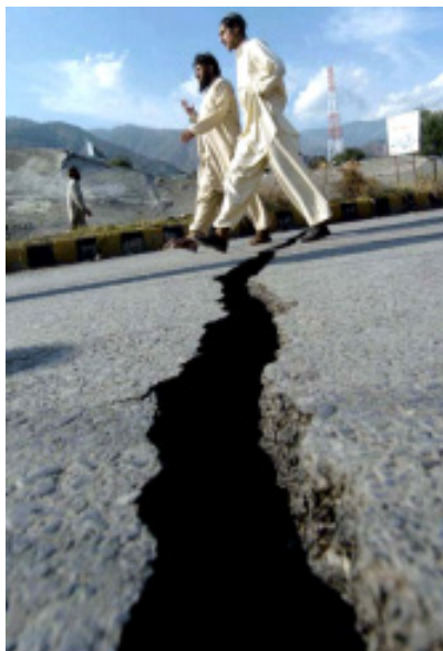
Slika 5. Potres je v slabih tleh povzročil nastanek obsežnih razpok Figure 5. Earthquake caused wide cracks
