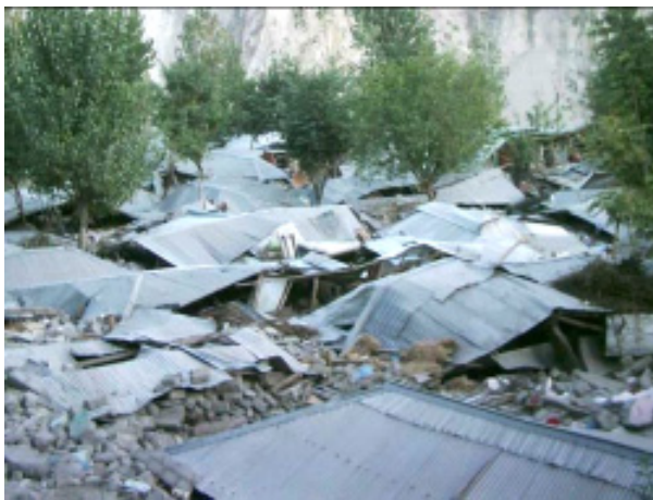
Slika 8. Poškodbe objektov, zgrajenih iz slabo povezanih betonskih blokov Figure 8. Damaged unreinforced concrete block masonry houses
