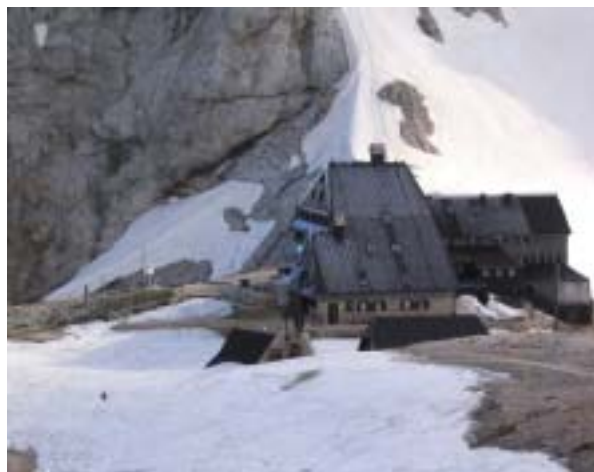
Slika 1.4.2. Meteorološka postaja na Kredarici je postavljena ob Triglavskem domu (slika: Špela Arhar)
