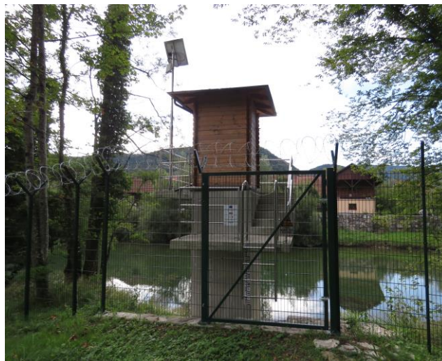
Slika 2. Hidrološka postaja Kolpa Petrina. Merilno mesto je opremljeno z vodomerno letvijo, avtomatskim tlačno-temperaturnim in radarskim senzorjem za izvajanje meritev pretoka in temperature vode. Merilno območje sega od 0 do 600 cm višine (foto: arhiv ARSO). Figure 2. Gauging station Kolpa Petrina (Photo: ARSO archive)
