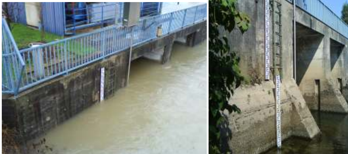
Slika 3. Vodomerna postaja Moste na Ljubljanici; levo: visoka voda decembra 2008; desno: nizka voda avgusta 2009 (foto: Arhiv ARSO)
