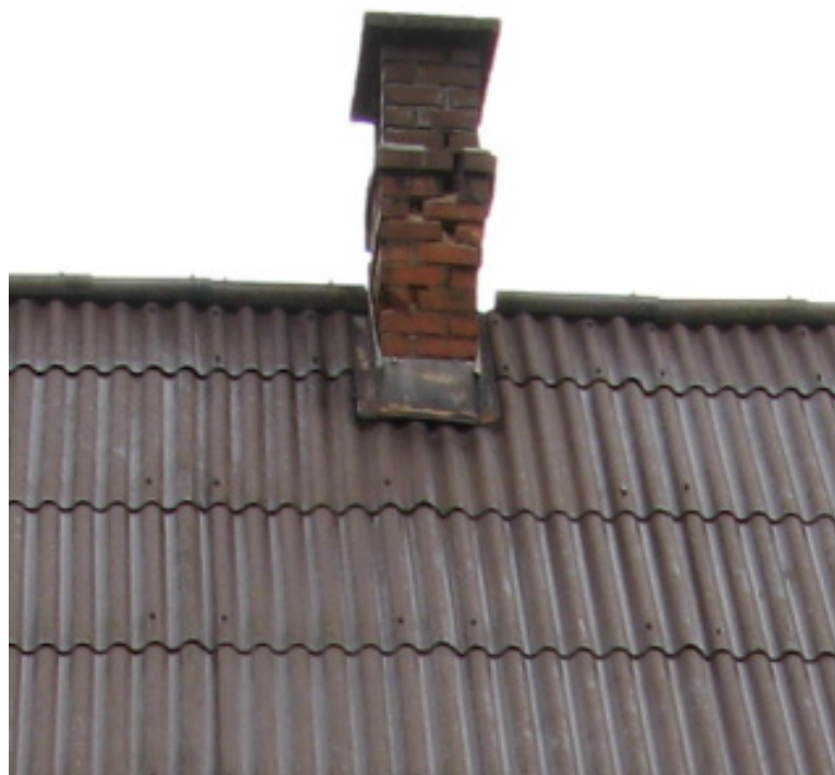
Slika 2. Poškodovan dimnik na hiši v Zagorju ob Savi (foto: Milka Ložar Stopar, ARSO, Urad za seizmologijo in geologijo)
