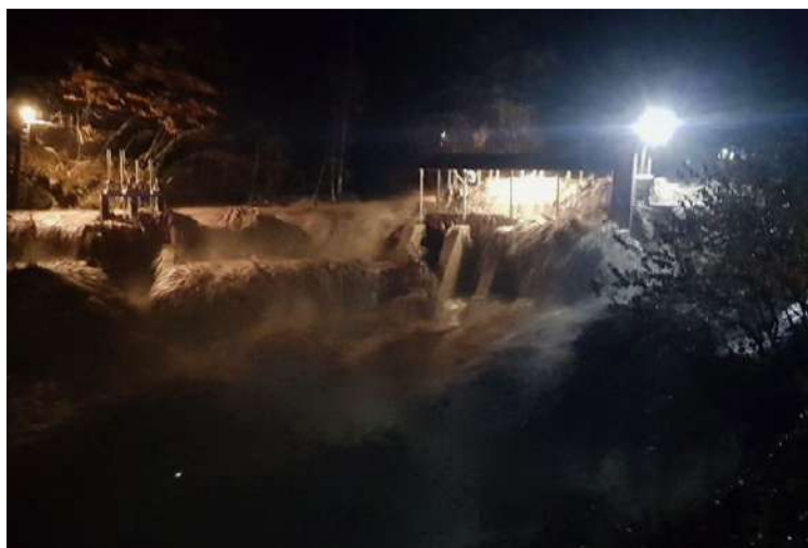
Slika 3. Hudourniške poplave Tržiške Bistrice v noči na 30. oktober 2018 Figure 3. The torrent flood of river Tržiška Bistrica at night on 30. October 2018
