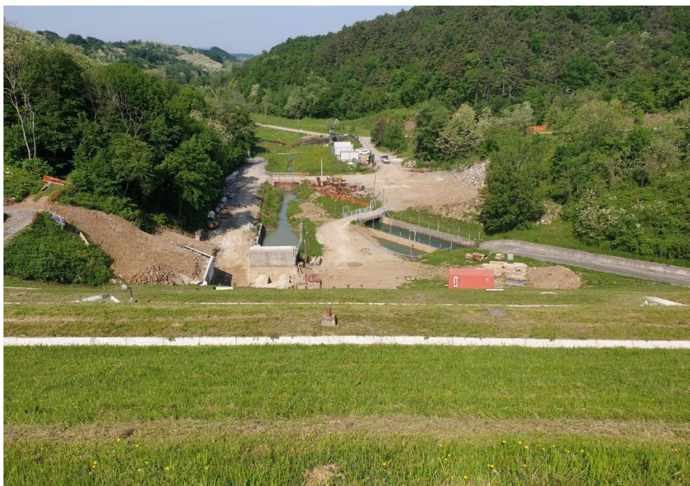
Slika 2. Iztok iz vodnega zadrževalnika v potok Vogršček (photo: M. Andjelov) Figure 2. Outflow from the water reservoir into the Vogršček stream (photo: M. Andjelov)
