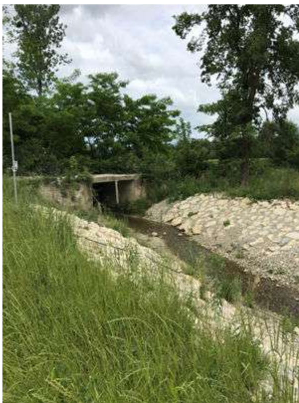
Slika 3. Odvod podzemne vode vodonosnika Krškega polja, projektiran ob izgradnji jezusa za hidroelektrarno Brežice (Foto: Urška Pavlič)
